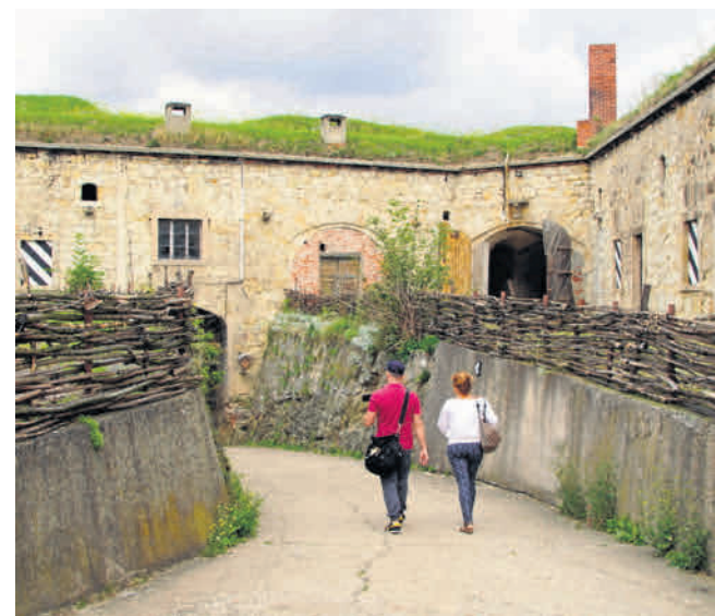
Tunel do bramy wyjazdowej z donżonu
